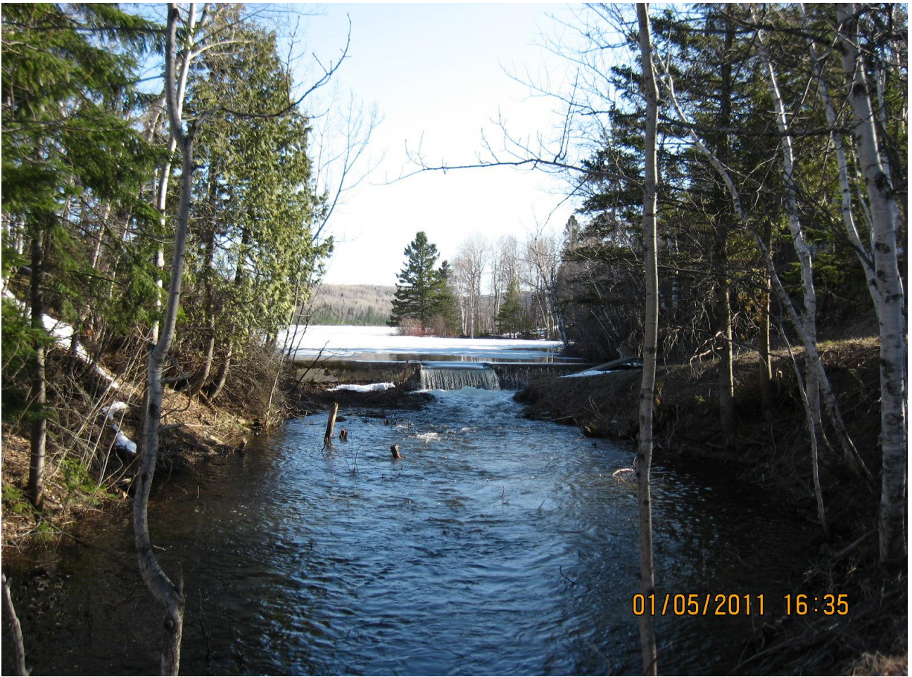
Barrage lac Anguille lors crue printanière en mai 2011(Source : Apela inc)
